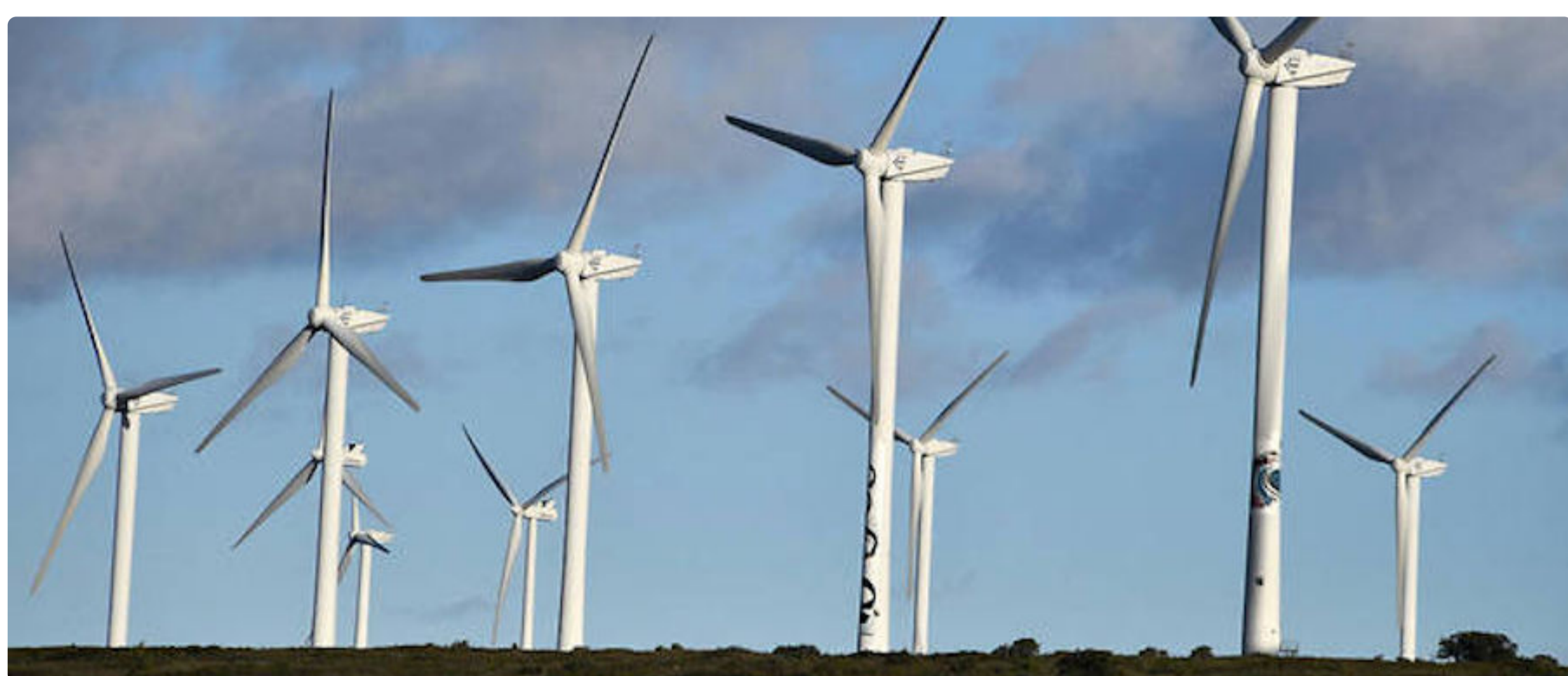
Un champ d'éoliennes à Villeveyrac dans l'Hérault.
